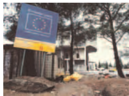
Bygging av brannstasjon i Serbia finansiert av EuropeAid
